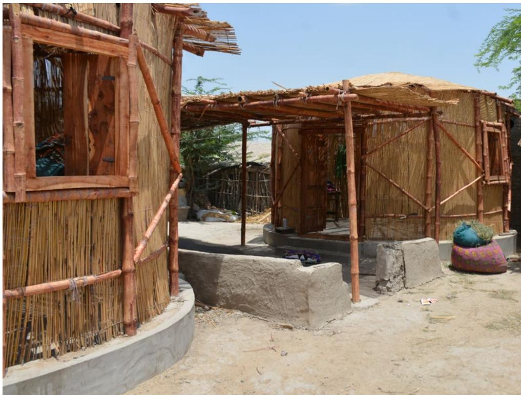
Le socle en béton doit permettre d'éviter que les nouvelles maisons ne soient emportées lors des prochaines fortes pluies de mousson.
